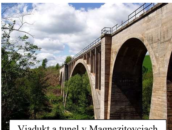
Viadukt a tunel v Magnezitovciach
