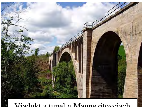
Viadukt a tunel v Magnezitovciach
